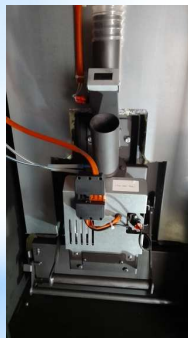
LIMPEZA AUTOMÁTICA DOS TURBULADORES
