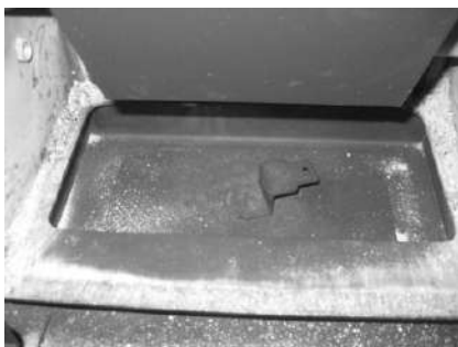
Figura 31 - Limpeza do interior da caldeira
