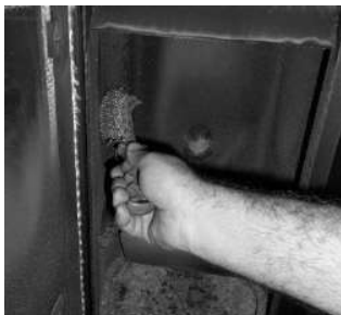
Figura 28 - Limpeza do interior da caldeira a água
