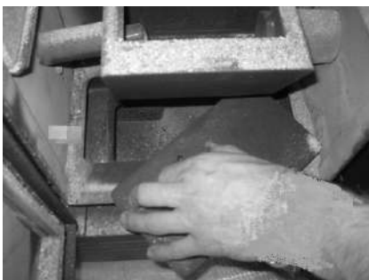
Figura 31 - Limpeza do interior da caldeira
