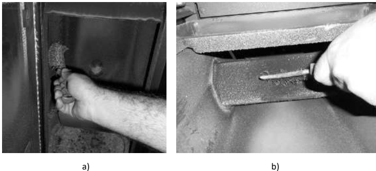
Figura 25 - Limpeza do interior da caldeira a água
