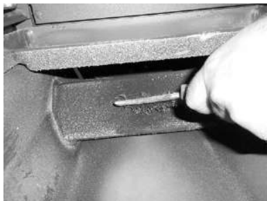
Figura 28 - Limpeza do interior da caldeira a água
