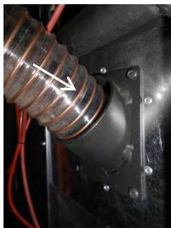
Figura 34 – Colocação do silo junto da caldeira (a); ligação do silo à cuba de pellets da caldeira (b e c)
