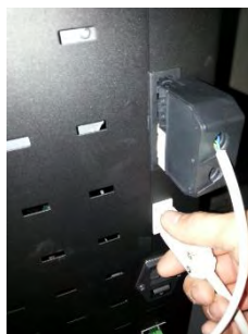
Figura 24 – Ligação cabo de corrente e dos sensores do silo a caldeira
