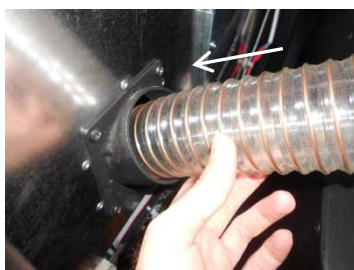
Figura 49 – Colocação do silo junto da caldeira (a); ligação do silo à cuba de pellets da caldeira (b e c)
